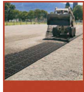
Relleno de la superficie de rejillas
