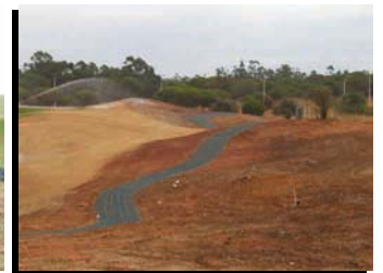
Relleno de la superficie de rejillas
